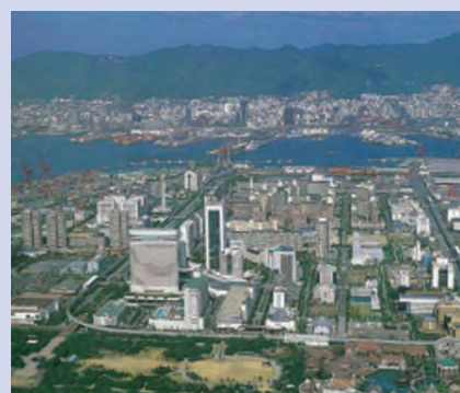
上空から見たポートアイランド
