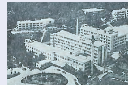
本館、中病棟、伝染病院、 衛生研究所がそろう
