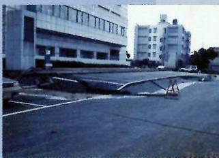
地盤沈下(駐車場)
